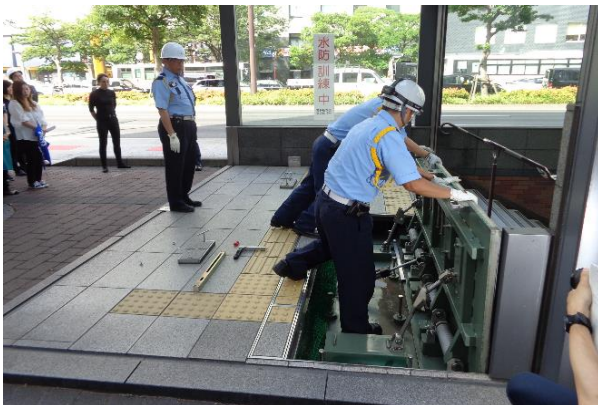
手動起上式止水板設置
