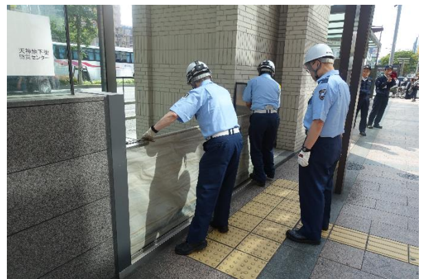
シート式止水板設置
