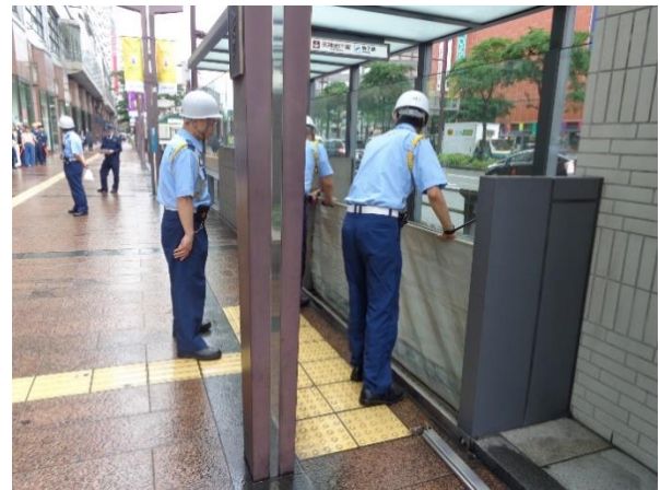
シート張り止水板設置
