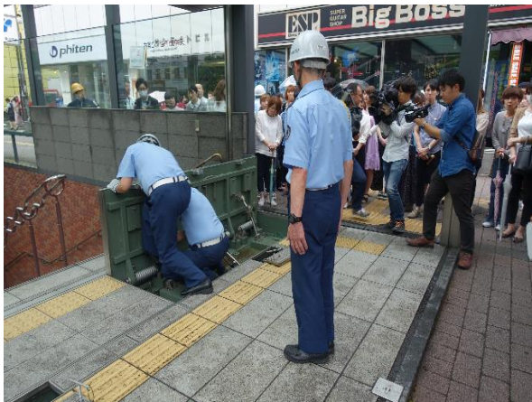
スプリング起上式止水板設置
